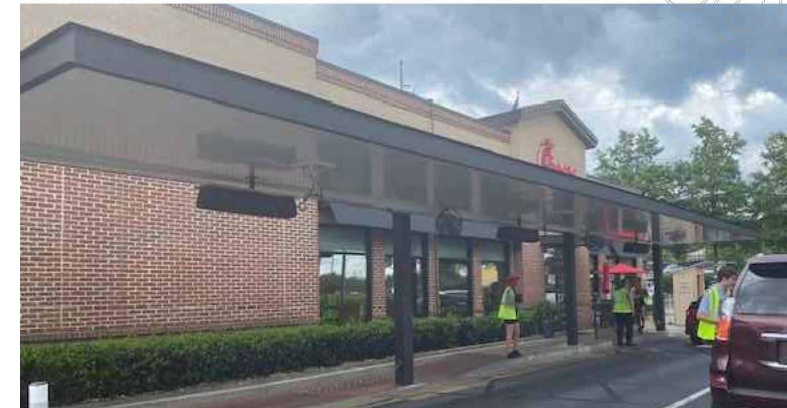
3 PHOTO: EXISTING CANOPY SCALE: N.T.S
