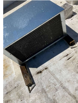
DXC-1 (WALK-IN FREEZER) CLEAN CONDENSER
