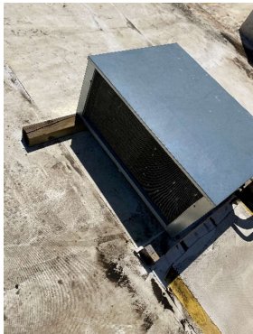
DXC-1 (WALK-IN FREEZER) DIRTY CONDENSER
