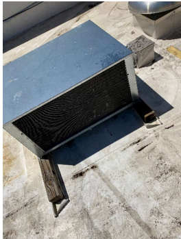
DXC-1 (WALK-IN FREEZER) DIRTY CONDENSER
