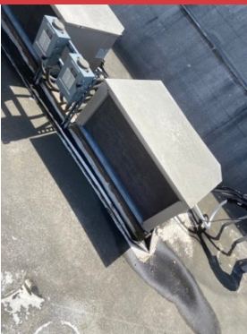
ACTUAL WALK IN COOLER CLEAN
