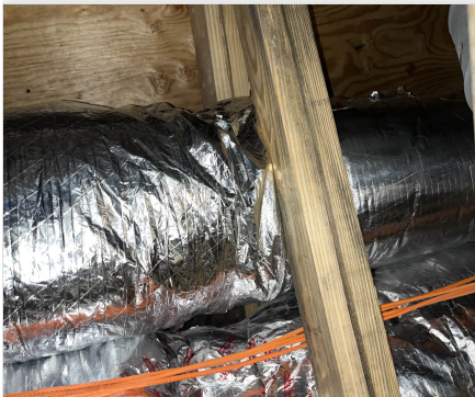
Missing_Damper_2_ 06/11/2024
