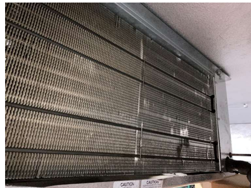
DXC-1 (WALK-IN COOLER) CLEAN EVAPORATOR
