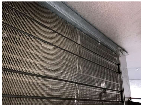
DXC-1 (WALK-IN COOLER) DIRTY EVAPORATOR
