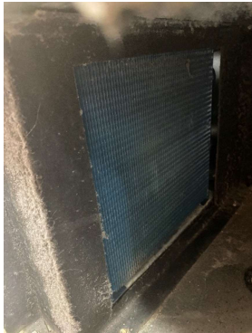
DXC-1 (WALK-IN COOLER) DIRTY EVAPORATOR
