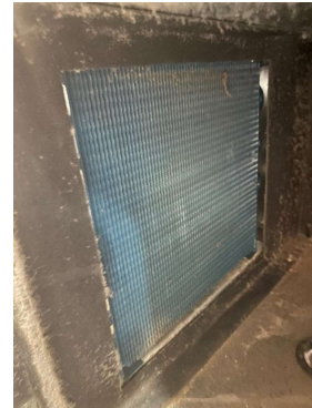
DXC-1 (WALK-IN COOLER) CLEAN EVAPORATOR
