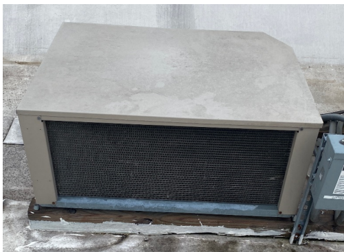
DXC-1 (WALK-IN COOLER) DIRTY CONDENSER
