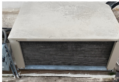
DXC-1 (WALK-IN COOLER) CLEAN CONDENSER
