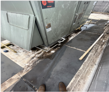
CONDENSATE-RTU3.jpeg
