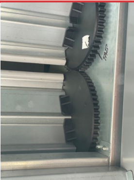
RTU2 OA SETPOINT
