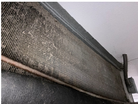
DXC-1 (WALK-IN COOLER) DIRTY EVAPORATOR
