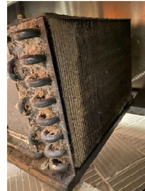
DXC-1 (WALK-IN COOLER) CLEAN EVAPORATOR
