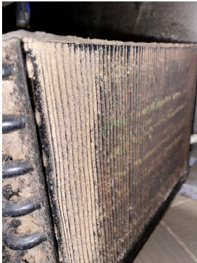
DXC-1 (WALK-IN COOLER) DIRTY EVAPORATOR
