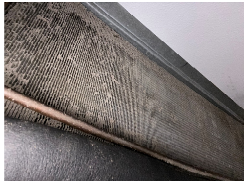
DXC-1 (WALK-IN COOLER) CLEAN EVAPORATOR
