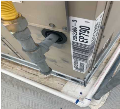
grommets_installed.jp...
