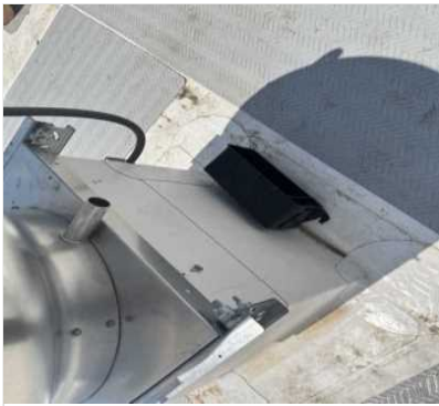
grease_cup_not_installed.jpg
