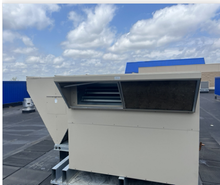
RTU-9filterdirty 07/16/2023
