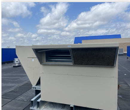
RTU-9filterdirty 07/16/2023
