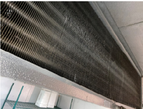
DXC-1 (WALK-IN COOLER) DIRTY EVAPORATOR
