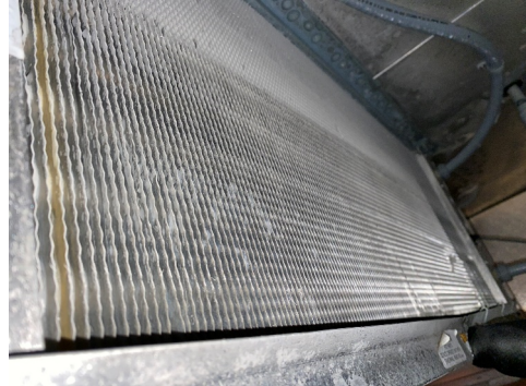
DXC-1 (WALK-IN COOLER) CLEAN EVAPORATOR
