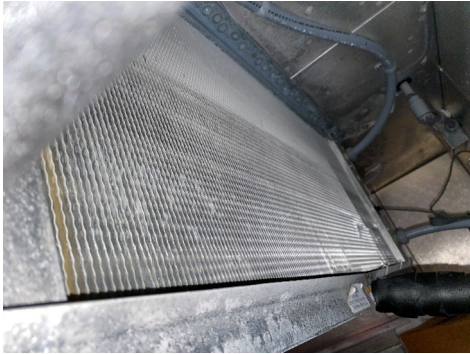
DXC-1 (WALK-IN COOLER) DIRTY EVAPORATOR
