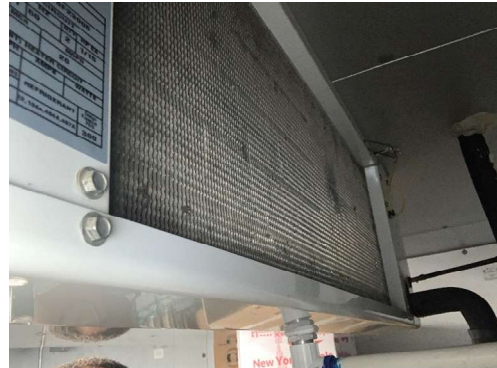
DXC-1 (WALK-IN FREEZER) CLEAN EVAPORATOR
