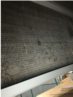
DXC-1 (WALK-IN FREEZER) DIRTY EVAPORATOR
