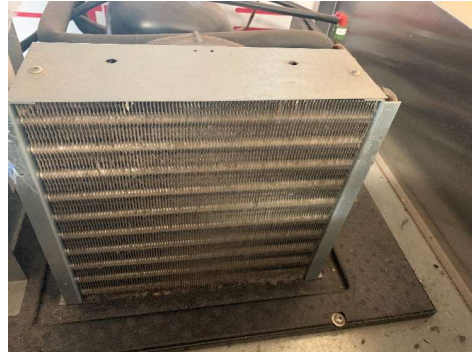
DXC-1 (WALK-IN COOLER) CLEAN EVAPORATOR
