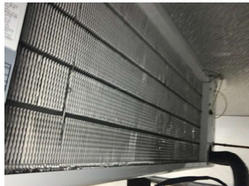
DXC-1 (WALK-IN FREEZER) CLEAN EVAPORATOR
