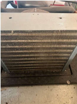
DXC-1 (WALK-IN COOLER) DIRTY EVAPORATOR
