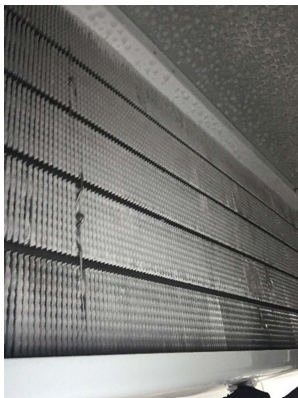
DXC-1 (WALK-IN FREEZER) DIRTY EVAPORATOR
