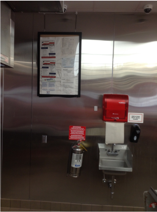
RTU4 / TEMP. SEN.
