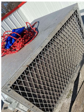
DXC-2 (WALK-IN FREEZER) DIRTY CONDENSER
