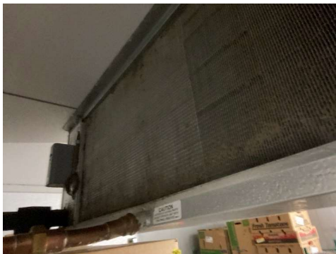
DXC-1 (WALK-IN COOLER) DIRTY EVAPORATOR
