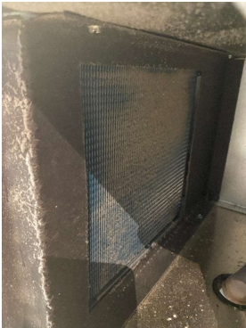
DXC-1 (WALK-IN COOLER) DIRTY EVAPORATOR
