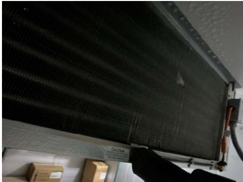
DXC-2 (WALK-IN FREEZER) DIRTY CONDENSER
