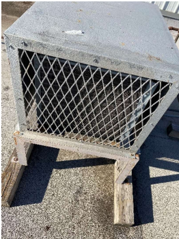
DXC-2 (WALK-IN FREEZER) DIRTY EVAPORATOR
