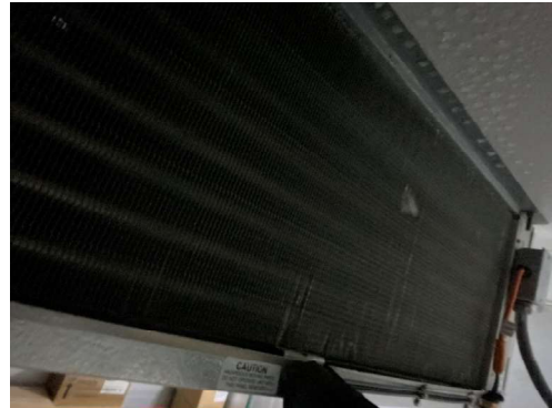
DXC-2 (WALK-IN FREEZER) CLEAN CONDENSER
