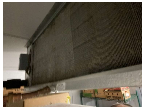
DXC-1 (WALK-IN COOLER) CLEAN EVAPORATOR
