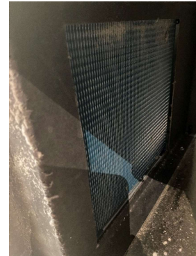
DXC-1 (WALK-IN COOLER) CLEAN EVAPORATOR
